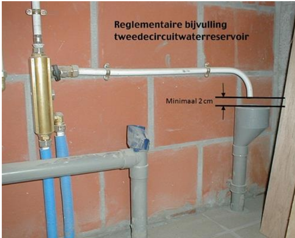
Figuur 3: AA-beveiliging bijvulling
