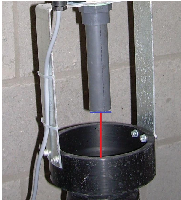
Figuur 5: bijvulstelsysteem zwembad: vrije uitloop
